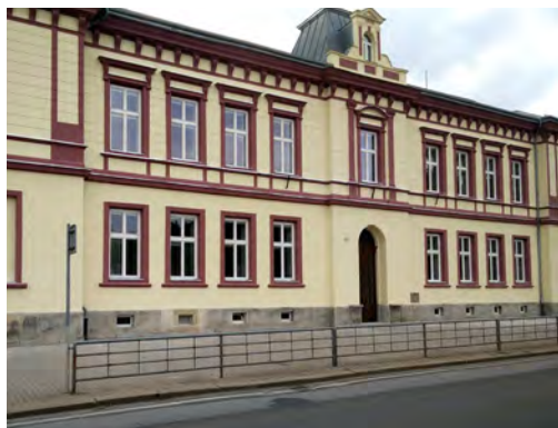
Fasáda a vchod budovy Horská 59 po rekonstrukci
