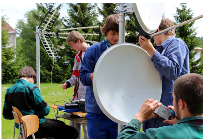
5. Instalace satelitu a antény
