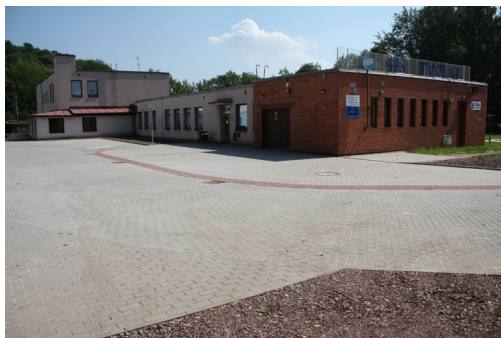
Příjezdová komunikace a parkoviště Horská 618 po rekonstrukci
