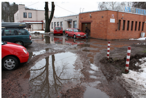
Příjezdová komunikace a parkoviště Horská 618 před rekonstrukcí
