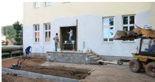
Vchod budovy Horská 59
