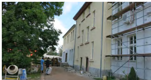
Rekonstrukce fasády a vchodu budovy Horská 59
