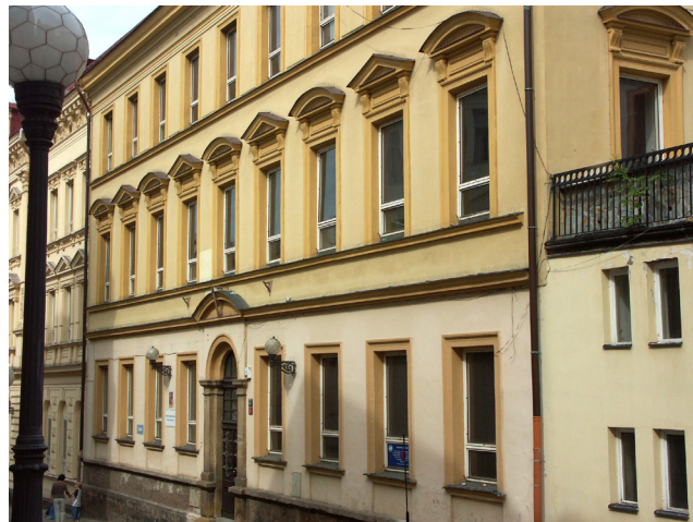
Sídlo školy a pracoviště teoretického vyučování Školní 101, Trutnov
