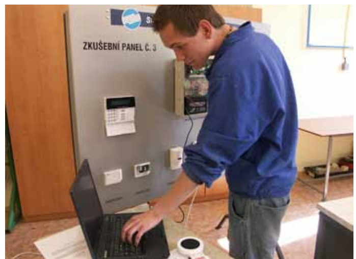
Zkušební panel zabezpečovací techniky
